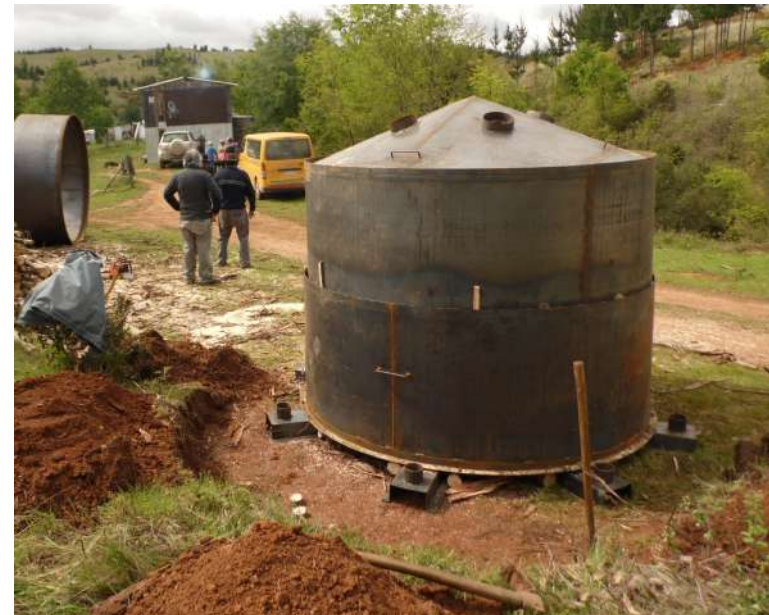
Nivelar el terreno alrededor del horno
