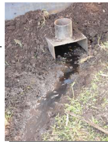
Salida de agua por troneras
