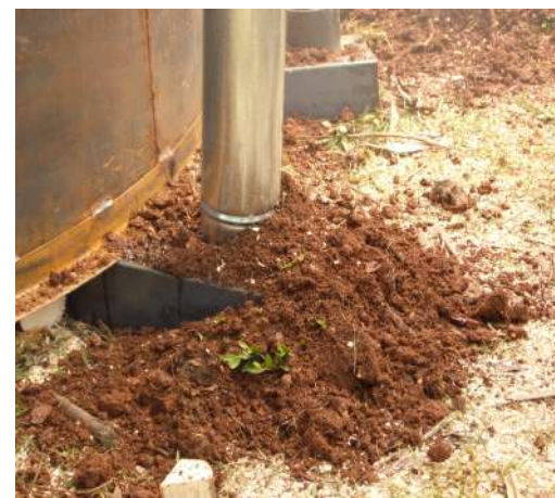
Cabeceras de troneras 30 / 32 Con cañones cerradas
