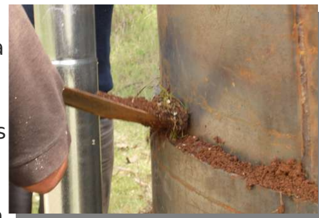
Sellar entre los cilindros con tierra
