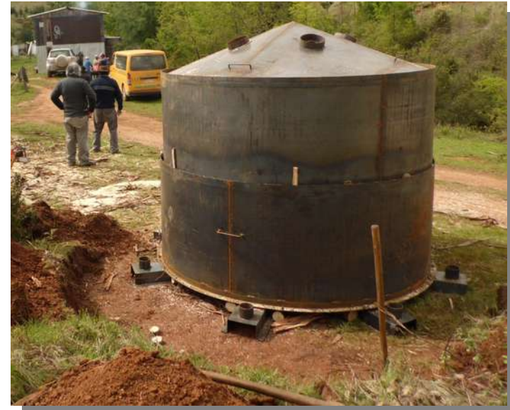
Nivelar el terreno alrededor del horno
